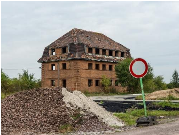
Die Ruine von Kressow wird im September abgerissen. Foto: Thomas Schäfer
