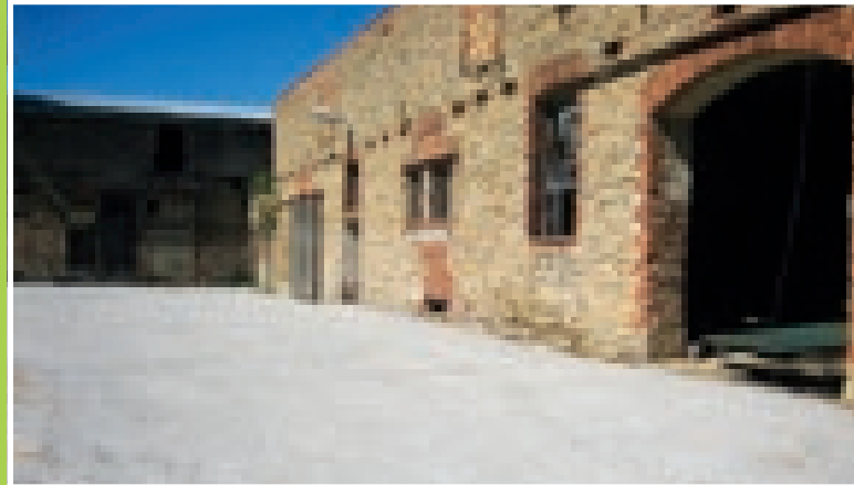
Aus alt mach neu: Das Scheunengebäude im Rittergut Giersleben vor der Umnutzung und Sanierung.
