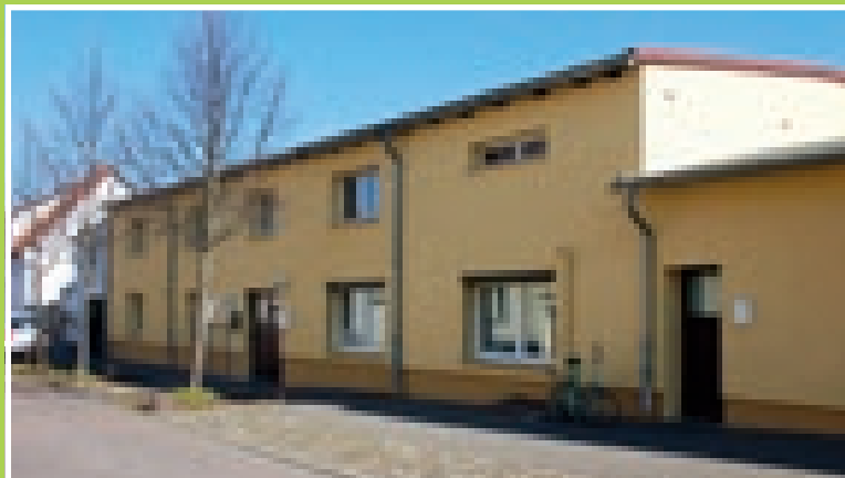
Ein zentraler Ort, nicht nur zum Sporttreiben: Die Mehrzweckhalle in Unseburg.
