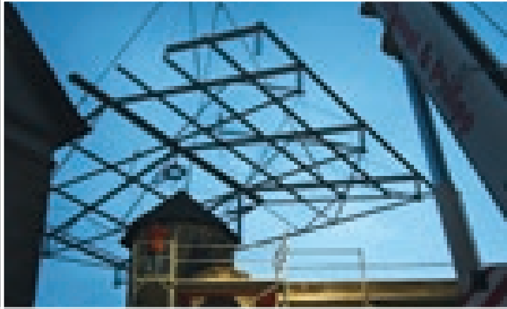
Das neue Dachgerüst des Seehäuser Gotteshauses wird mittels Kran auf die Kirchenmauern aufgesetzt. (Foto: Dr. Helmut Schröder)
